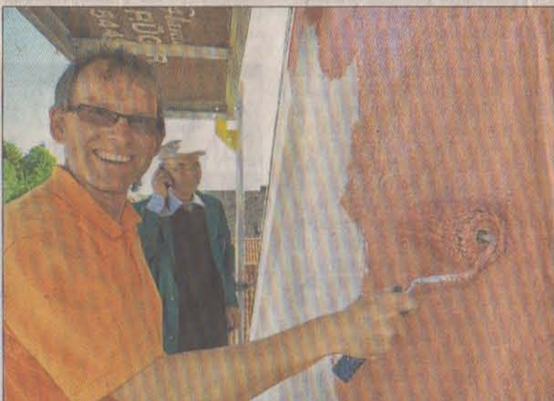
Malermeister Frank Krüger streicht das Haus in einem hellen Rotton vor. Der zweite Anstrich wird kräftiger. Jürgen Meier überwacht die Arbeiten und telefoniert schon mit dem nächsten Handwerker.
